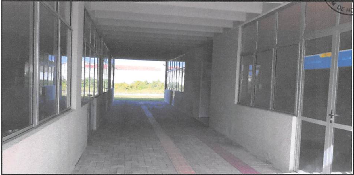
FOTO 07 VISTA DA CIRCULAÇÃO DO PRÉDIO DESTINADO A IMPLANTAÇÃO DE UMA UNID. DE CAMPANHA DE ENFRENTAMENTO DO COVID-19
