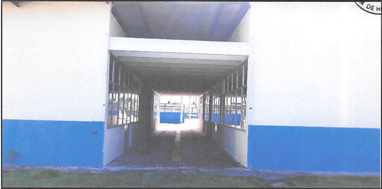
FOTO 05 VISTA DOS FUNDOS DO PRÉDIO DESTINADO A IMPLANTAÇÃO DE UMA UNID. DE CAMPANHA DE ENFRENTAMENTO DO COVID-19
