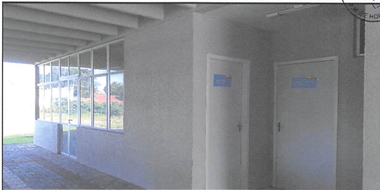
FOTO 09 VISTA DA CIRCULAÇÃO DO PRÉDIO DESTINADO A IMPLANTAÇÃO DE UMA UNID. DE CAMPANHA DE ENFRENTAMENTO DO COVID-19
