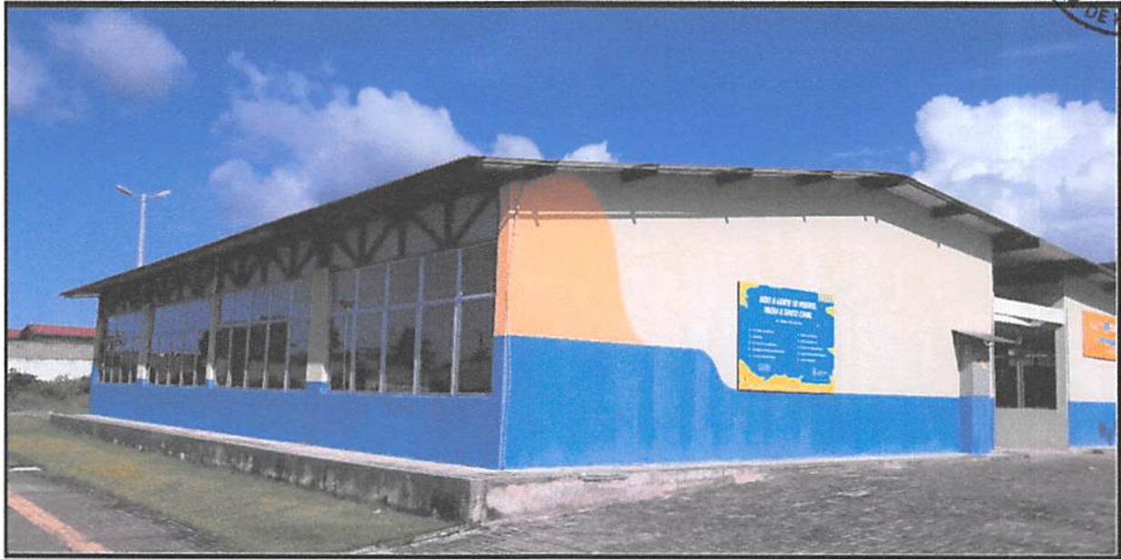
FOTO 03 VISTA LADO DIREITO DO PRÉDIO DESTINADO A IMPLANTAÇÃO DE UMA UNID. DE CAMPANHA DE ENFRENTAMENTO DO COVID-19
