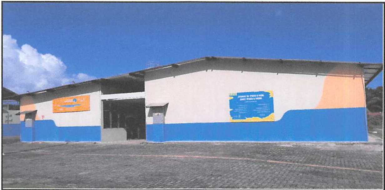
FOTO 04 VISTA DE FUNDOS DO PRÉDIO DESTINADO A IMPLANTAÇÃO DE UMA UNID. DE CAMPANHA DE ENFRENTAMENTO DO COVID-19
