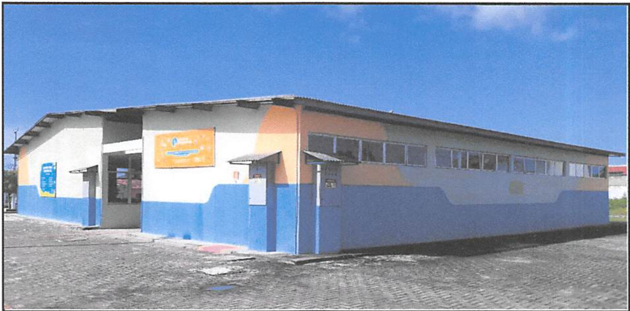
FOTO 06 VISTA LADO ESQUERDO DO PRÉDIO DESTINADO A IMPLANTAÇÃO DE UMA UNID. DE CAMPANHA DE ENFRENTAMENTO DO COVID-19
