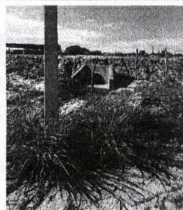
FOTO Nº 3 RUA JUAREZ CORREIA DE LIMA BAIRRO DISTRITO INDUSTRIAL
