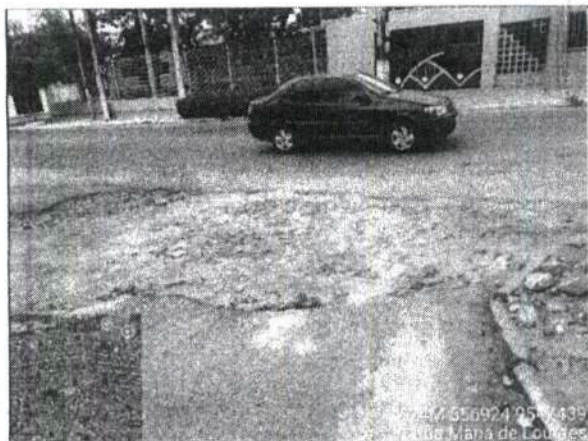
FOTO Nº RECUPERAÇÃO ASFÁLTICA
