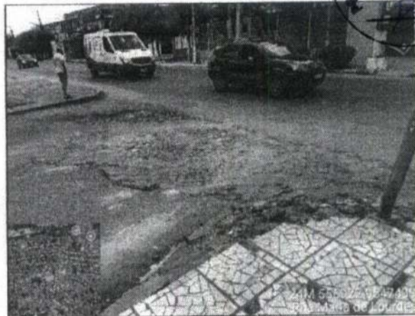
FOTO Nº RECUPERAÇÃO ASFÁLTICA
