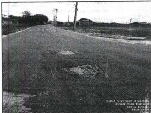
FOTO Nº RECUPERAÇÃO ASFÁLTICA
