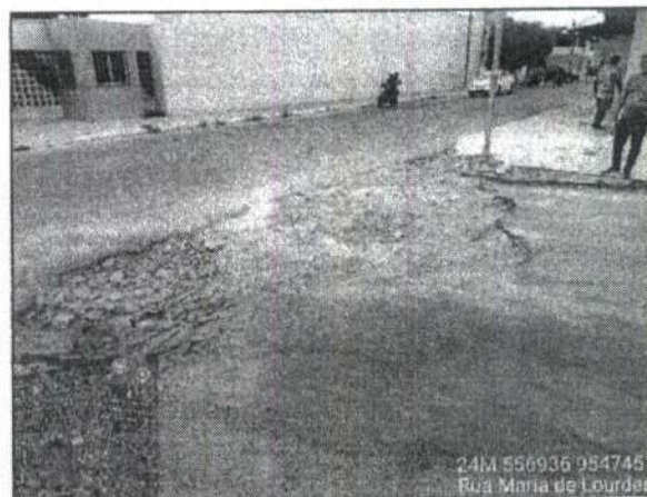
FOTO Nº RECUPERAÇÃO ASFÁLTICA
