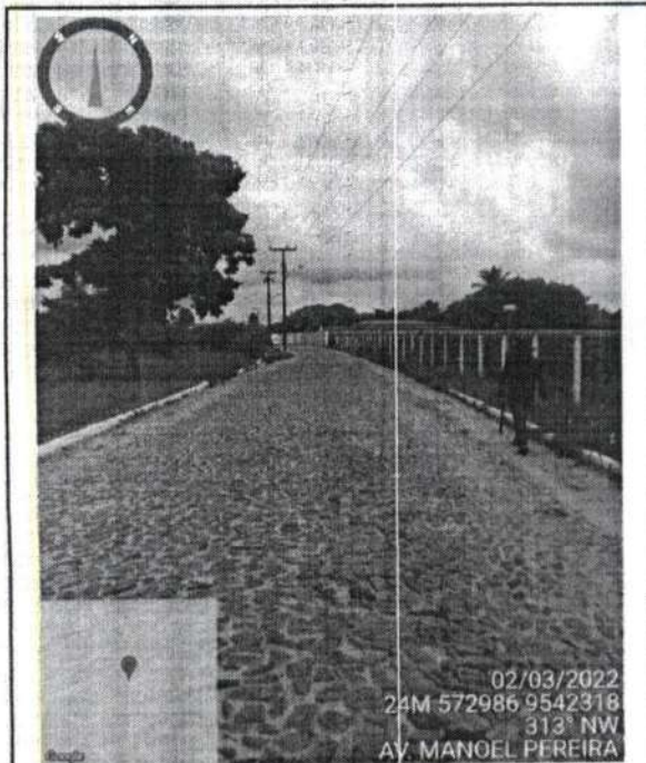
FOTO Nº PAVIMENTAÇÃO EXISTENTE 13 DISTRITO DE ANINGAS
