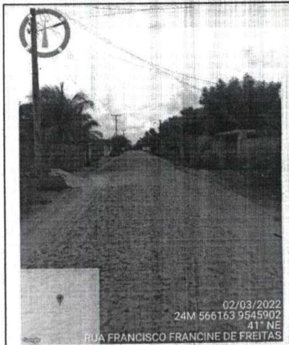
FOTO Nº PAVIMENTAÇÃO EXISTENTE 2 DISTRITO DE ANINGAS
